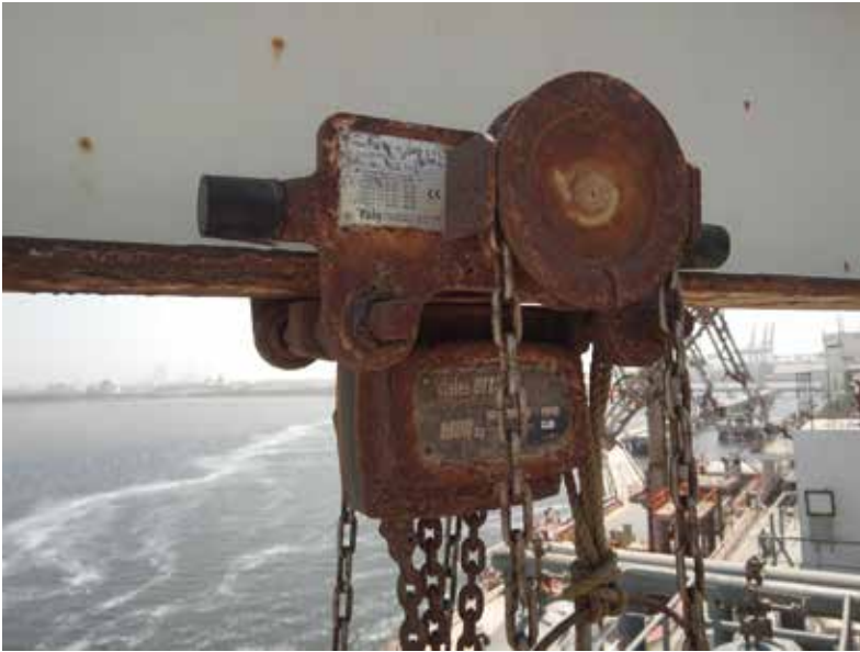
Korrodiertes Yalelift Flaschenzug mit integriertem Fahrwerk – nach 9 Jahren im Einsatz weiterhin funktionsfähig
